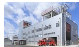
①消防本部・西脇消防署
