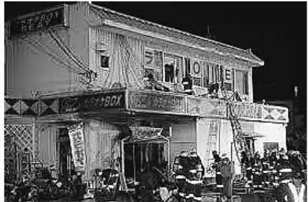
〔07年 宝塚市内カラオケ店火災〕 消防用設備等が機能せず、3名の方が犠牲となりました。 「東京法令出版株式会社 事例から学ぶ防火管理 抜粋」
