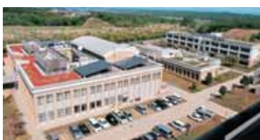
▲兵庫県消防学校
