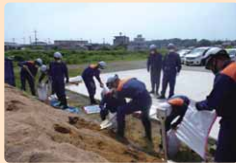
土のう作製の状況
